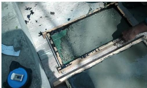
FIG.3.11: LAYING OF SCC LAYER BY LAYER
